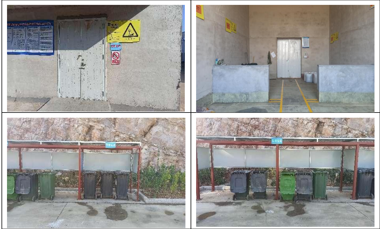
图4.1-2 危废间和一般固废间图片
